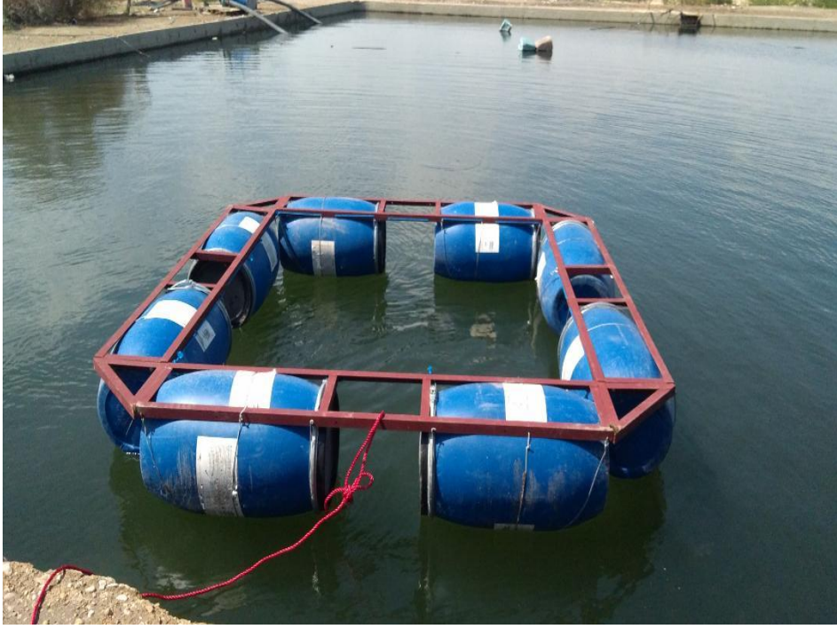
صوره للقفص العائم أثناء وضعه قبل 48 ساعة من تركيب الشباك للتأكد من سلامة الطوافات .
